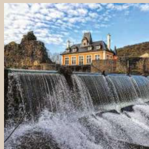
Centrale hydroélectrique d'Ambialet @patprp
