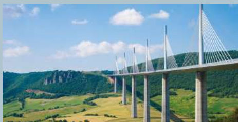
Le Viaduc de Millau
